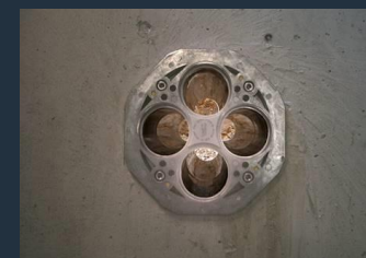
Fertige Wanddurchführungen für Luft, Wasser, etc
